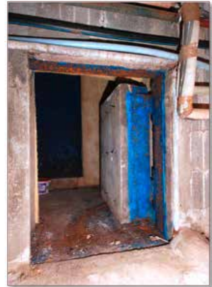
Stahlbetontüre zum Kellerverließ - aus Fritzls tabuem Werkraum von links unten gebückt zu betreten
