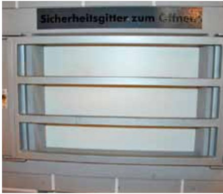
Mit einem versperrbaren Gitter sichern Sie Kellerfenster
