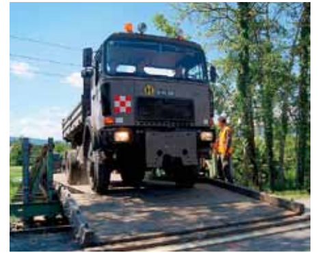
Behelfsmäßige Brücke vom Bundesheer errichtet (Fotohinweis: BH HF)
