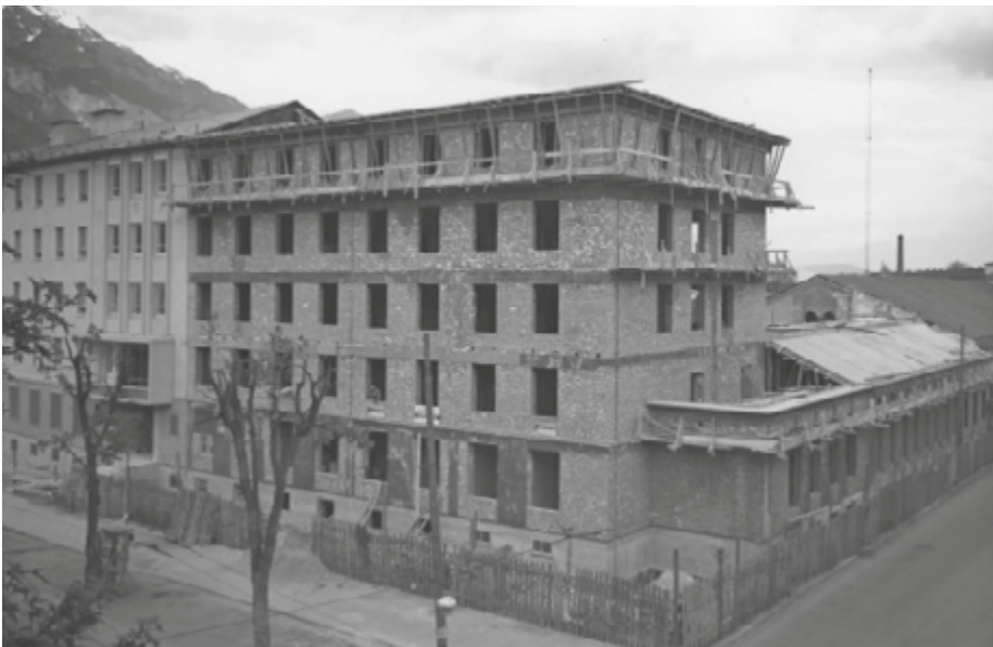
Neubau der Polizeidirektion Innsbruck
