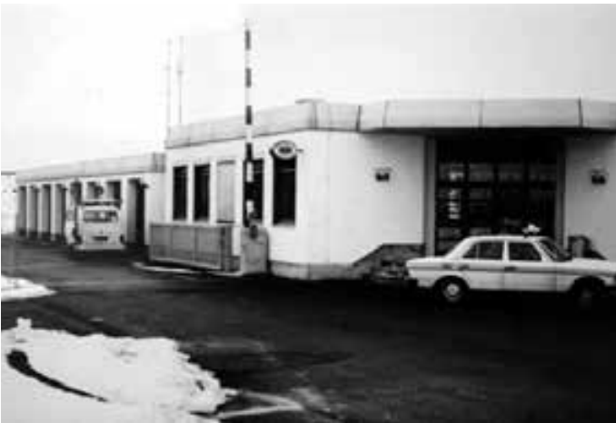
Eingangsbereich der neuen Dienststelle nach der Fertigstellung 1980 mit Mercedes als Dienstfahrzeug
