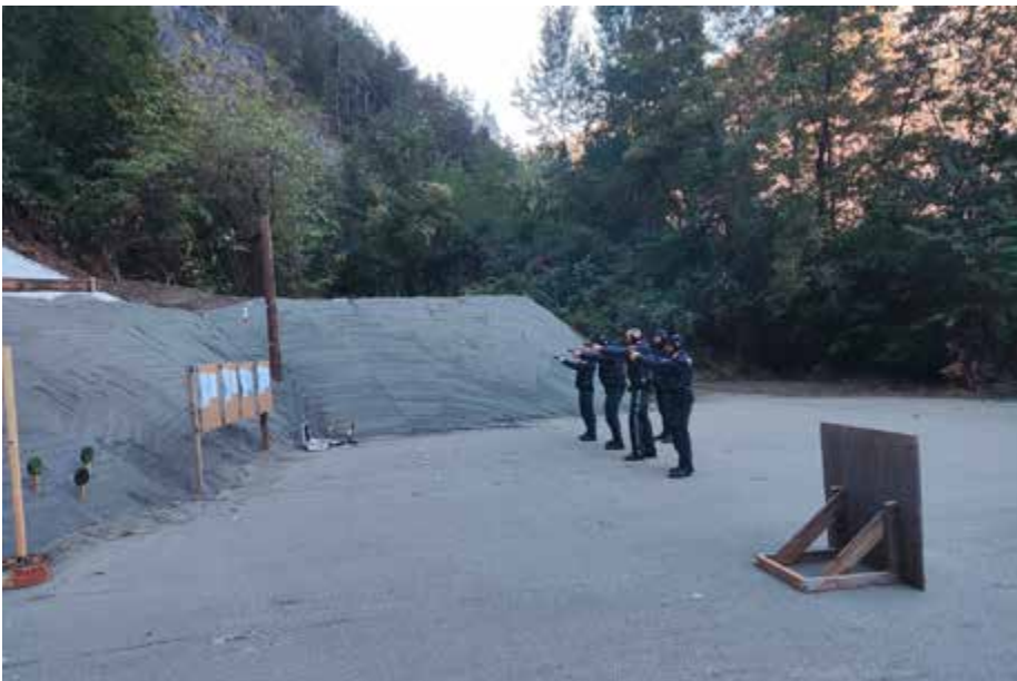
Der fertiggestellte Schießstand in Landeck
