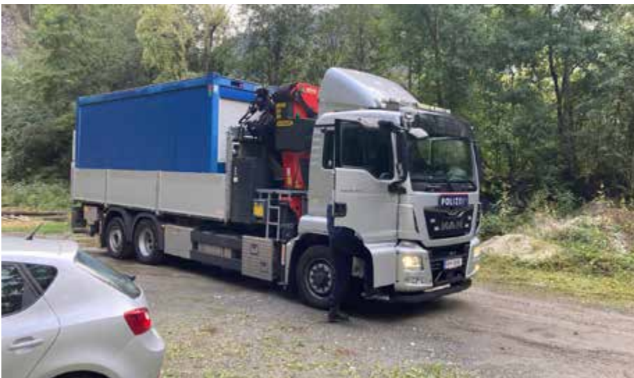
Bautätigkeiten beim neuen Schießstand und Anlieferung des Containers
